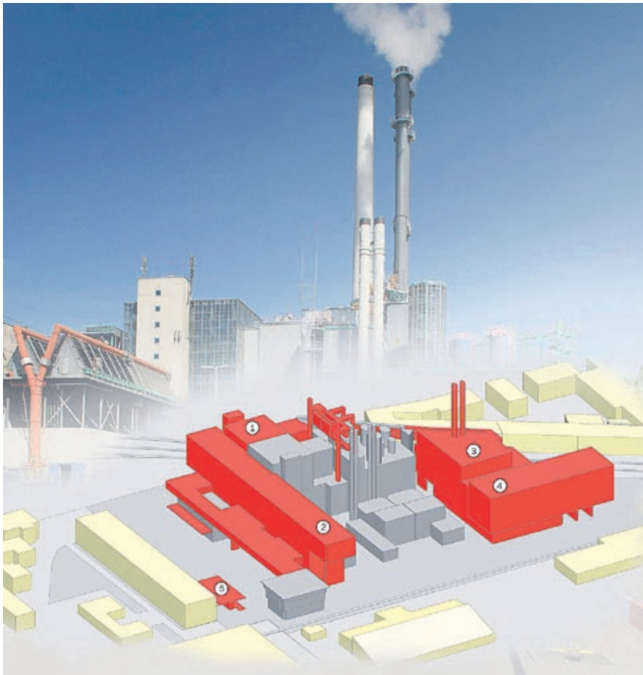
Die KVA wird zur Grossbaustelle. Rot eingefärbt sind jene Anlagenteile, die verändert werden. Bild: awo/Grafik: Stadtwerk/Montage: sts
