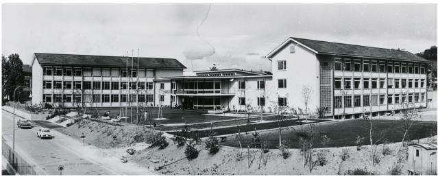
Das Schulhaus Rosenau besteht aus einem dreigeschossigen Real- und Sekundarschultrakt, die durch einen Verbindungsbau verbunden sind. Dank vorgefertigten Betonelementen realisierten wir den Bau relativ schnell. Die Eröffnung fand im Jahr 1963 statt.
