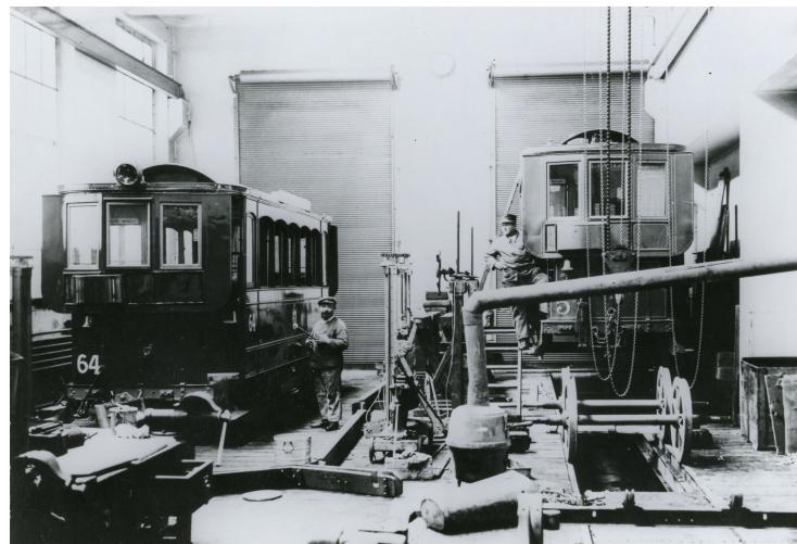
um 1923: Tösstalstrasse 86, Tramdepot Deutweg, Umbau von zwei Motorwagen zu Anhängern, Gottlieb Manz und Gottlieb Grob Foto: winbib (Signatur 042460)
