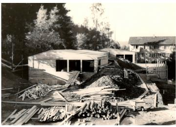
Kindergarten Gerzler im Bau. Da sich das Gebäude in Hanglage befindet, muss zuerst ein provisorischer Zugang für den Transport der Baumaterialien angelegt werden, 1962.
