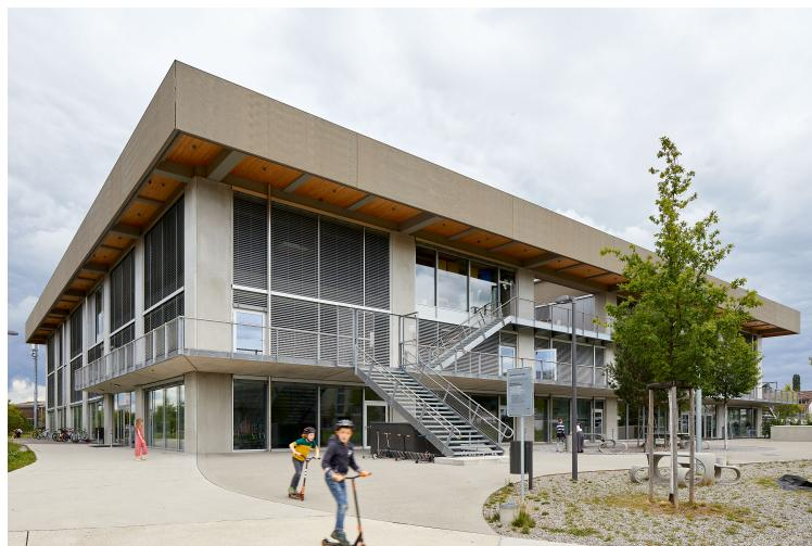
Im 2018 fertiggestellten Schulhaus sind alle Einrichtungen unter einem Dach vereint: von den Turnhallen über die Klassenzimmer bis zu den Lernlandschaften. 24 Betonpfeiler tragen das Dach, auf dem eine Photovoltaikanlage Strom erzeugt.
