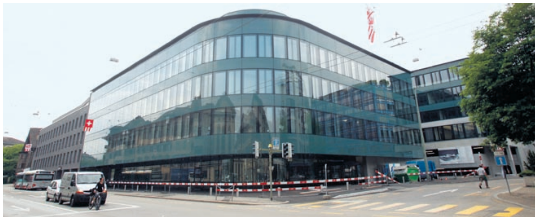
In der Fassade der «Eulachpassage» auf dem ehemaligen Areal der Eulachgarage spiegelt sich die Altstadt – auf die der Glaspalast formal keinen Bezug nimmt. Bild: Donato Caspari
