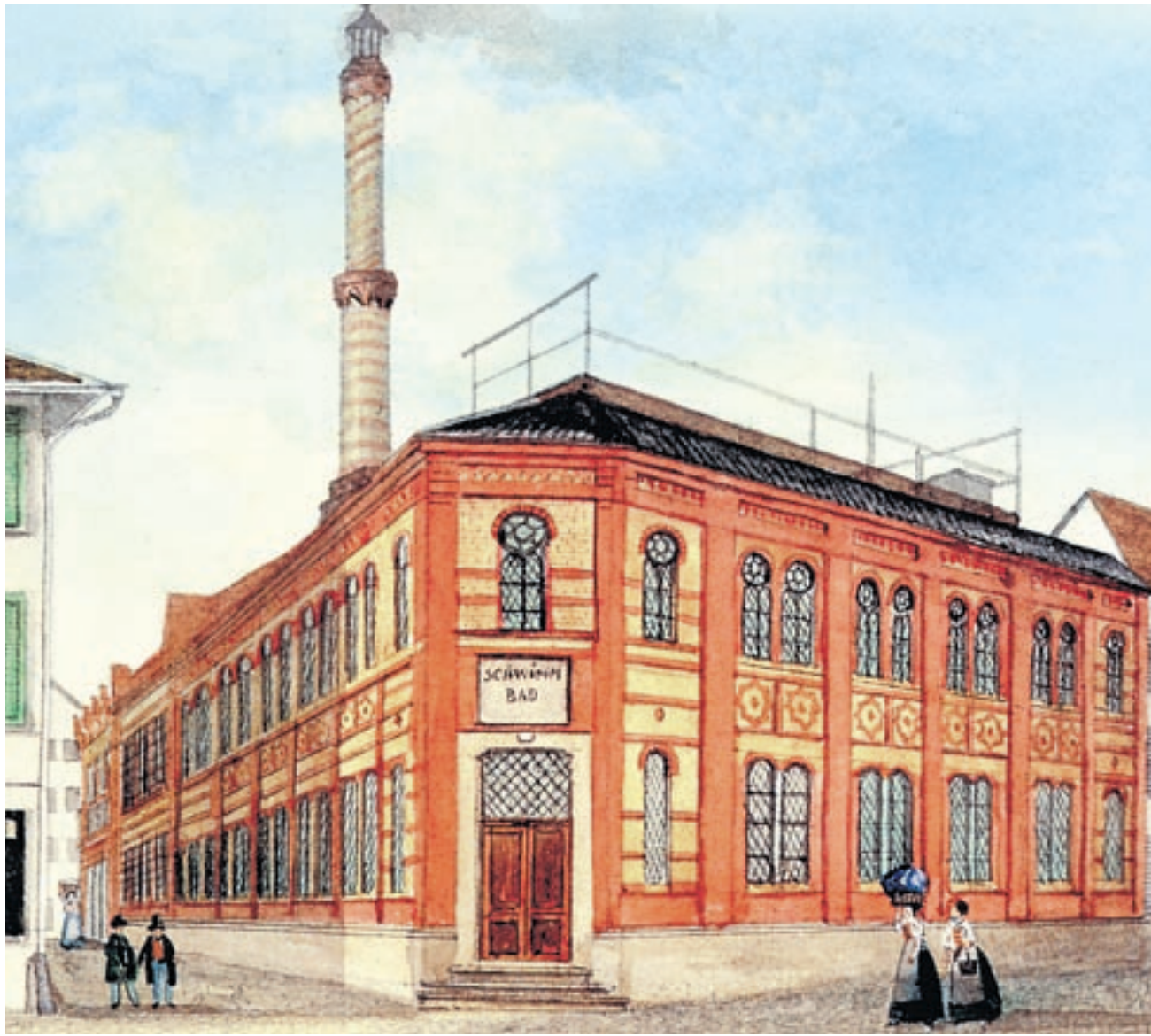
Die Bad- und Waschanstalt an der Badgasse kurz nach der Eröffnung, gemalt 1868 von Jakob Ziegler. Bild: winbib-Sondersammlungen
