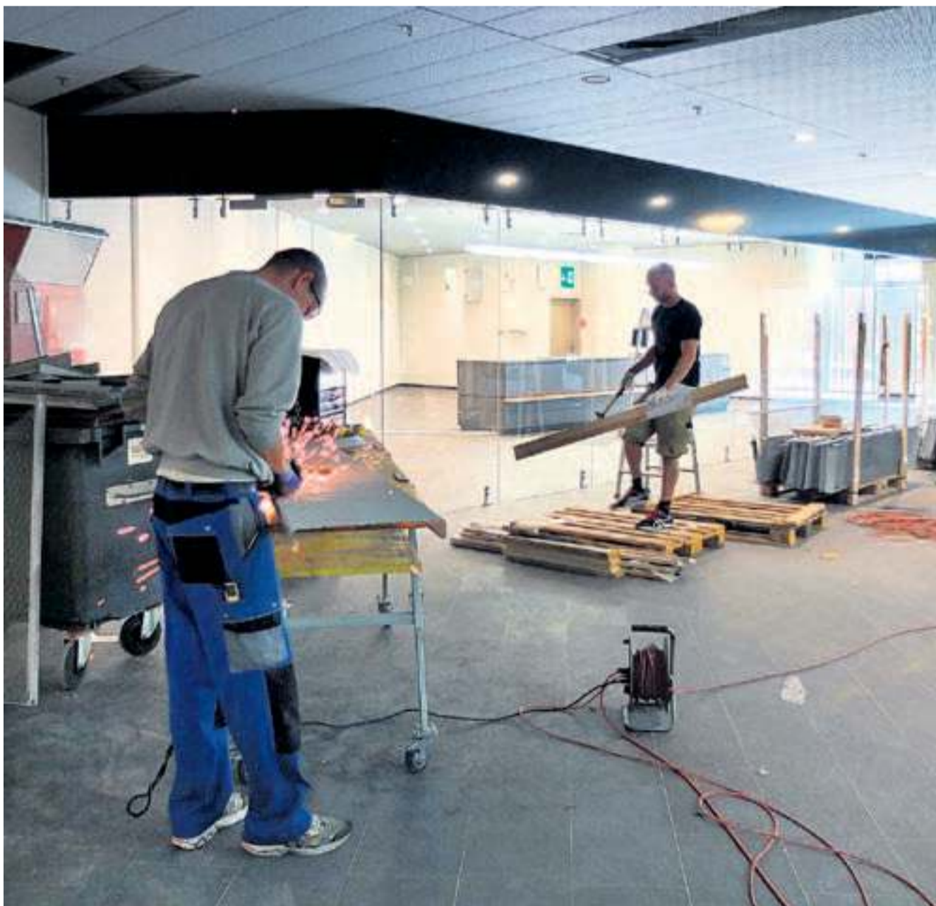
Letzte Arbeiten im Einkaufszentrum Deutweg, im Hintergrund die Postfiliale, die am Donnerstag neu eröffnet wird. Bild: Marc Dahinden
