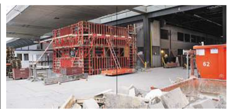
Das einstige Pförtnerhäuschen wird nach aussen verlängert und beherbergt in Zukunft die Leitstelle.
