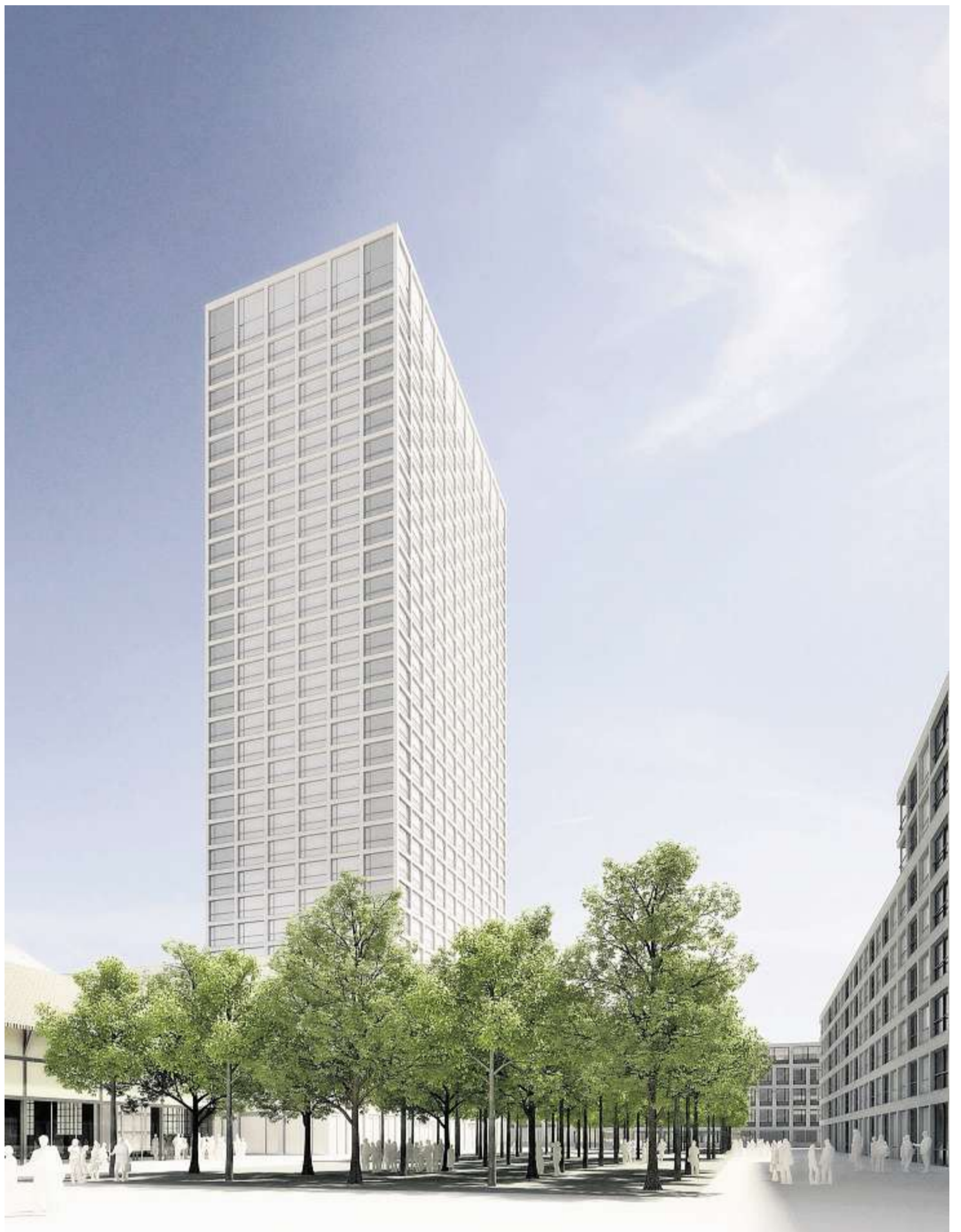
Das 100-Meter-Hochhaus auf dem Sulzer-Areal kann gebaut werden. Man werde «hundertprozentig» Investoren finden, heisst es bei Implenien. pd
