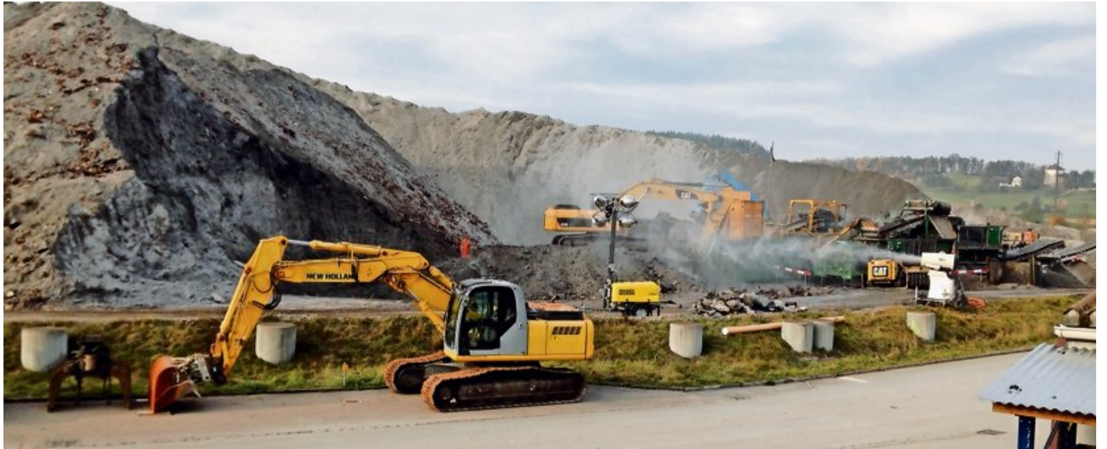
Gegen zwölf Meter hoch ist der Schlackenberg links. Er wird sukzessive abgebaggert und weiter verarbeitet. Beim Zerkleinern der Schlackenklumpen entsteht Staub, der mit dem Sprühnebel der Schneekanone (weiss) gebunden wird. zvg
