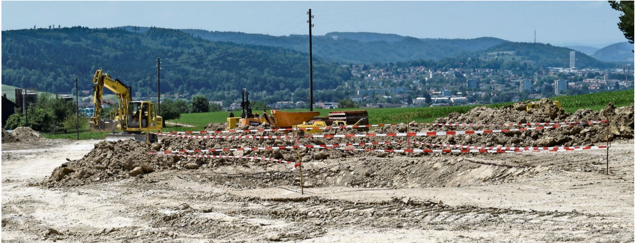
Die Vorarbeiten mit Blick auf die Stadt sind zu Ende, in den nächsten Tagen beginnt der Bau des Trinkwasserspeichers oberhalb von Oberseen.
