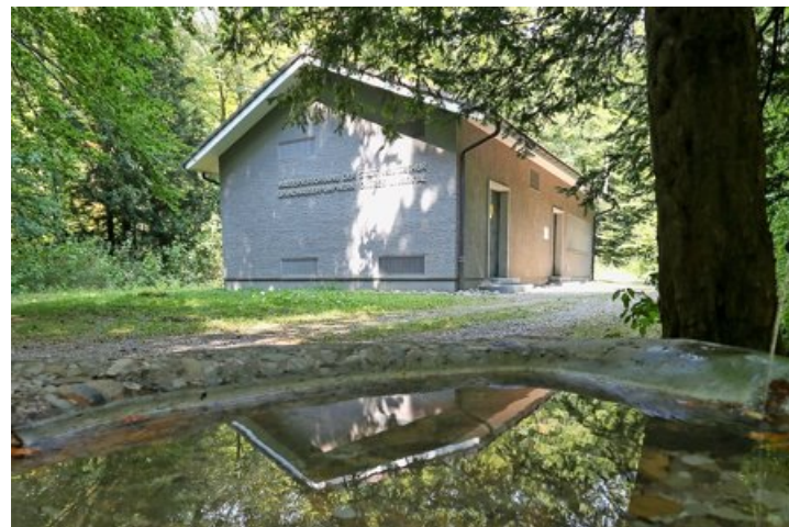
Das Pumpwerk oberes Linsental spiegelt sich in einem Brunnen.
