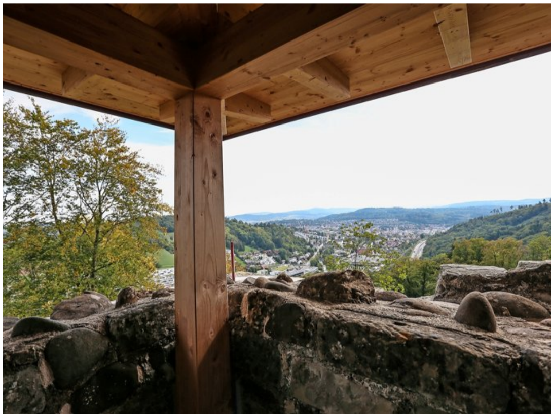
Feuerstelle, Dach und Aussicht: Die Burgruine ist mit diesen Neuerungen wieder ein Ausflugsziel. Fotos: Nathalie Guinand
