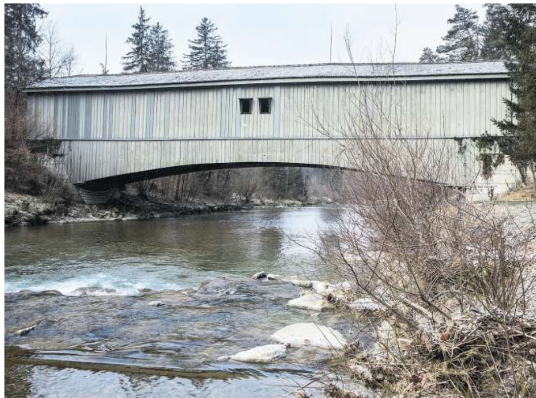
Die Brunibrücke wurde 1839 für die Strasse Winterthur-Embrach bei Pfungen gebaut. Seit 1974 steht sie beim Reitplatz oberhalb Winterthur Töss.
