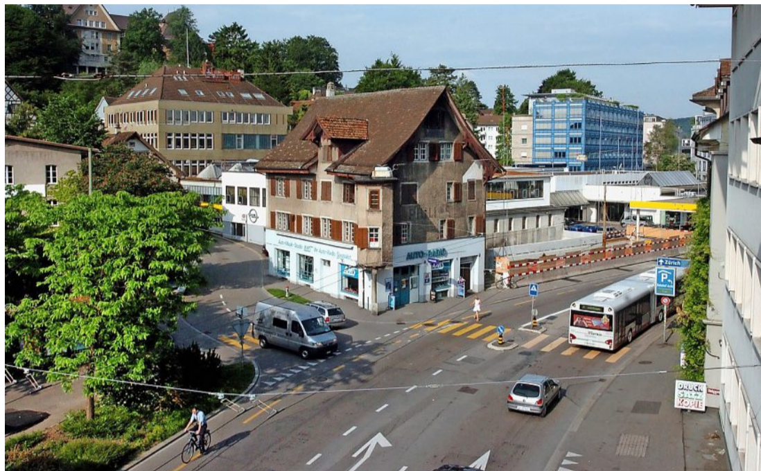
Die chemische Reinigung hinterliess Schadstoffe: 2005 wird das Hölken-Areal saniert. Archivbild: Marc Dahinden
